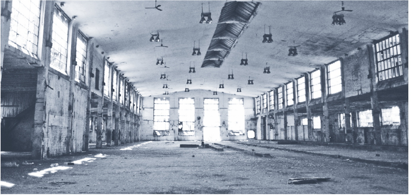
Verlassene Fabrikhalle des im Jahr 2000 geschlossenen Rohrleitungswerks in Muldenstein (Sachsen-Anhalt).
